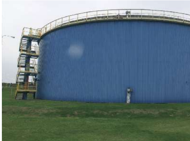
Obecnie proces fermentacji, podczas którego powstaje biogaz, odbywa się w otwartej komorze. W przyszłości zastąpią ją zamknięte komory, w których gaz będzie wylapywany
