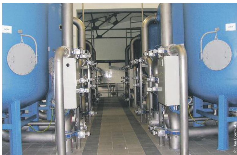
W stacji wymieniono na nowe wszystkie urządzenia
