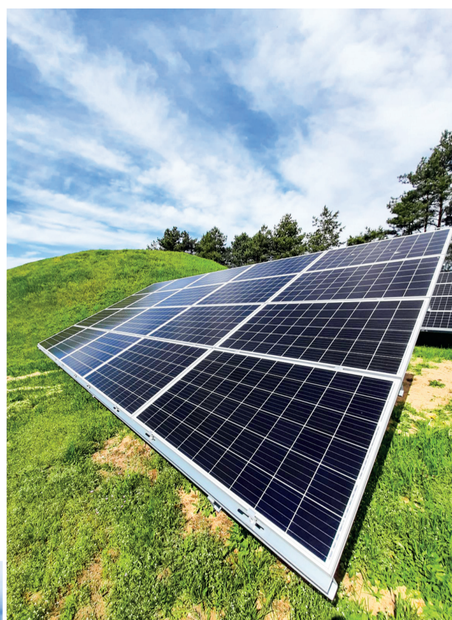
▲ W instalacji zastosowano moduły monokrystaliczne o mocy 330 Wp z serii Extreme polskiego producenta firmy Bruk-Bet Fotowoltaika. Moduły posiadają bardzo dobre parametry techniczne potwierdzone certyfikatami wiodących instytucji oraz ośrodków badawczych. Dodatkowo oprócz standardowej 25-letniej gwarancji na moc, moduły posiadają 20-letnią gwarancję na produkt, zapewniając tym samym użytkownikowi poczucie spokoju i bezpieczeństwa.
