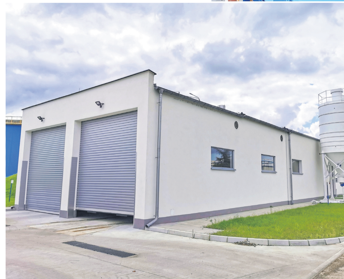
Zmodernizowany budynek stacji odwadniania osadów wraz z silosem na wapno.
